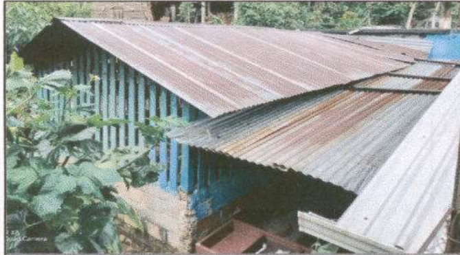
Foto 1. Sustrucción de lámina por lámina troquelada Aluzinc
