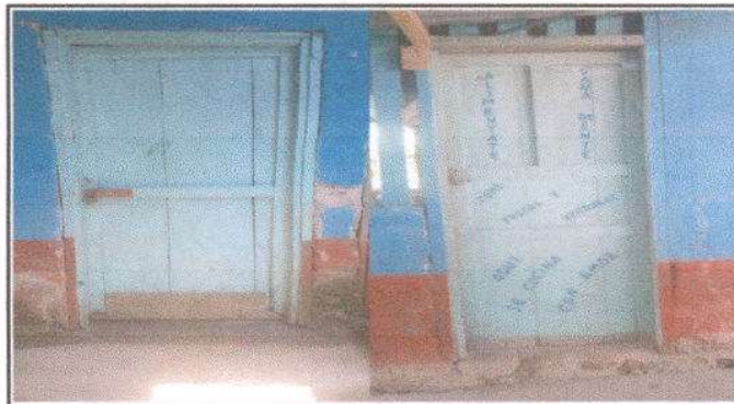
Foto 3. Sustrucción de puertas de madera por metal
