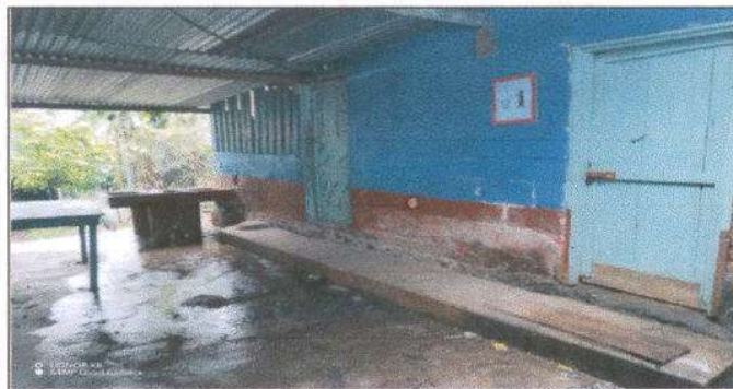
Foto 5. Sustrucción de pinturas en paredes
