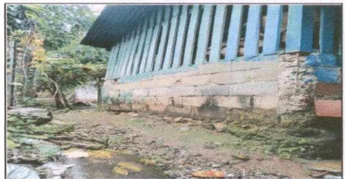
Foto 6. Sustrucción de muro perimetral
